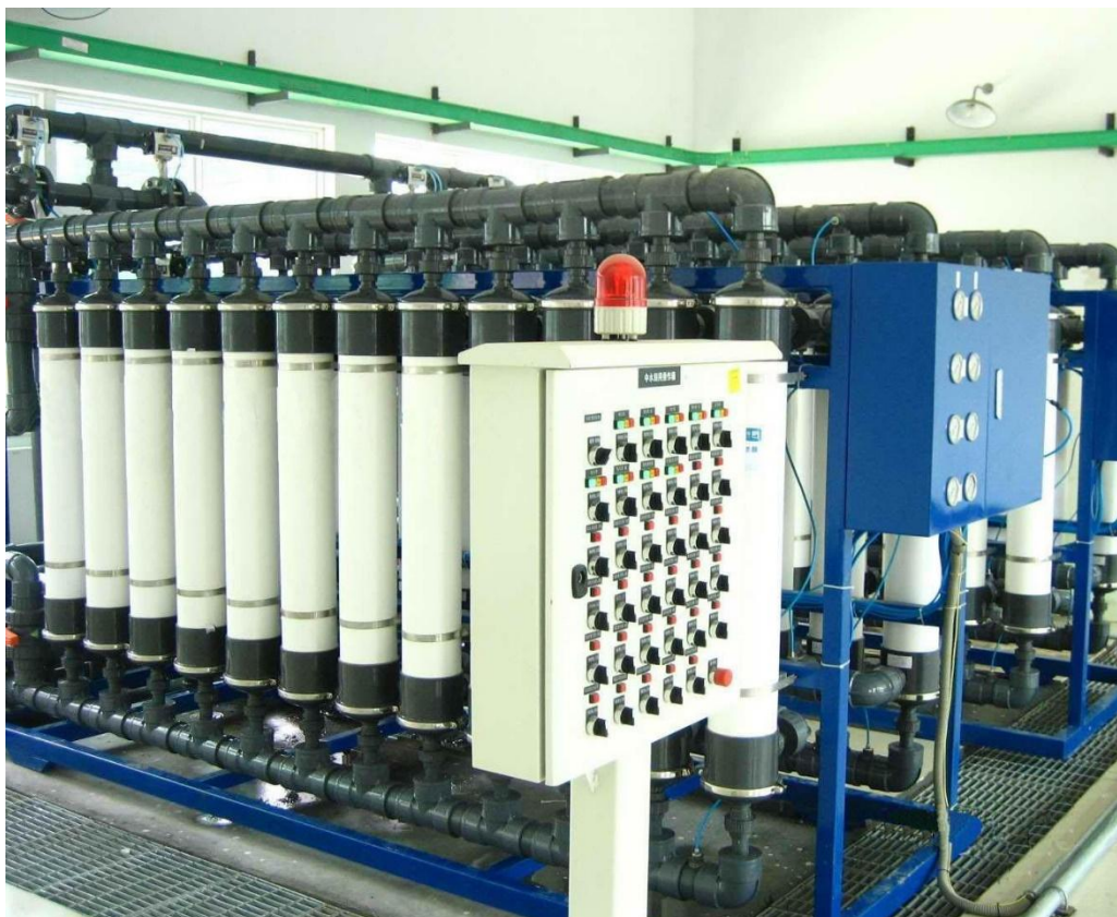
阳谷森泉水厂公司日处理 2 万吨再生水回用设备
